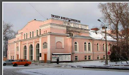
Фото 2009 года (до ремонта)
