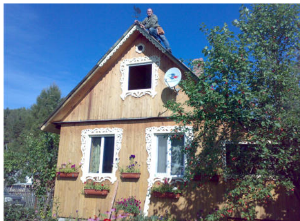
Дача. Саша устанавливает флюгер.
