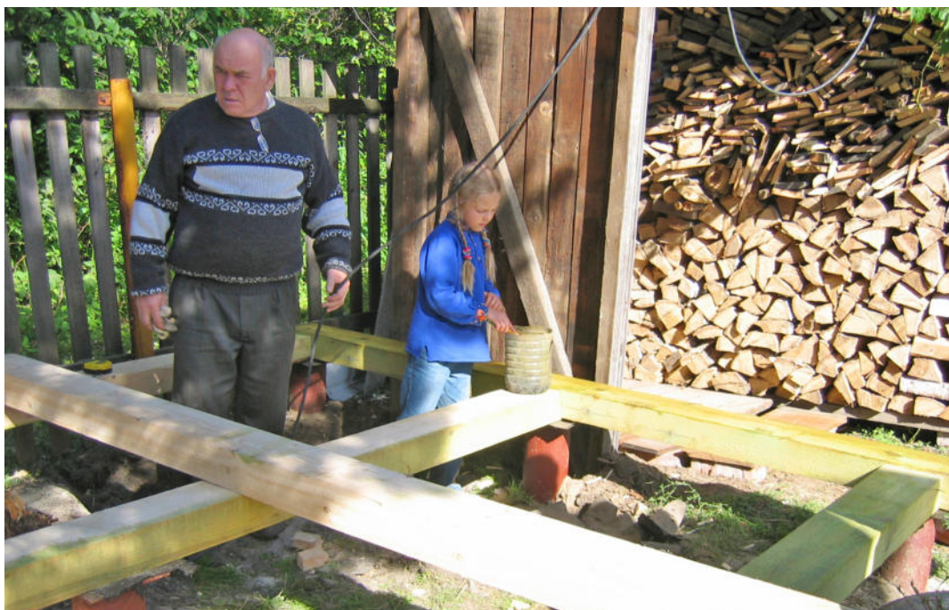
Стройка на даче. Я с внучкой Соней.
