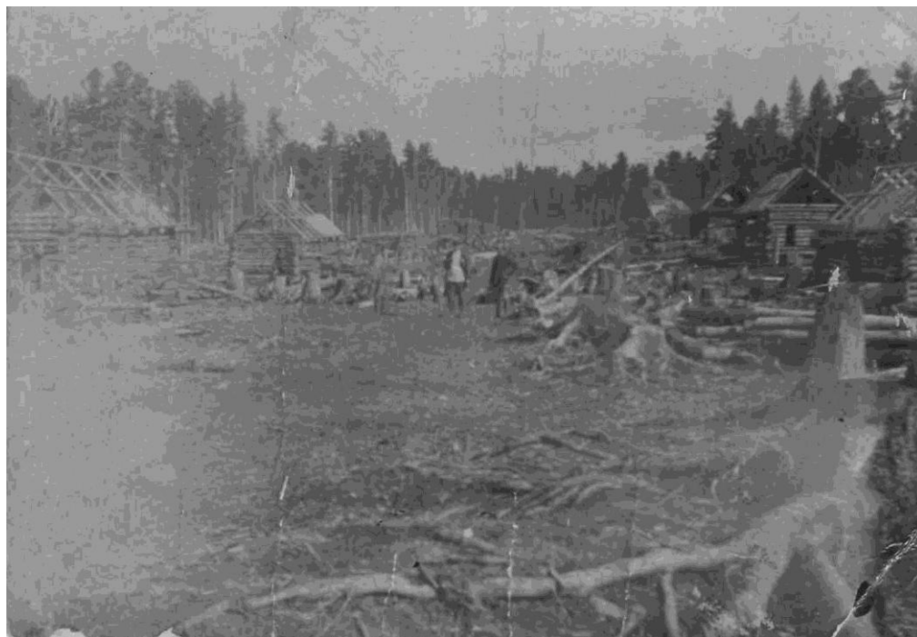
6. Строительство жилищ и других построек в одном из спецпоселков Зачулымья в 1930-е годы. III спецпереселенческий участок. Фото из архива Ю. А. Мартыненко.
