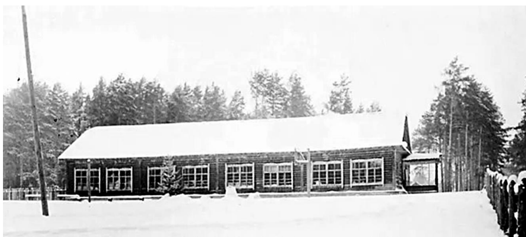
Тимирязевская средняя школа, 1954 г. Одноэтажное здание (барачного типа) построено в 1946 году.
