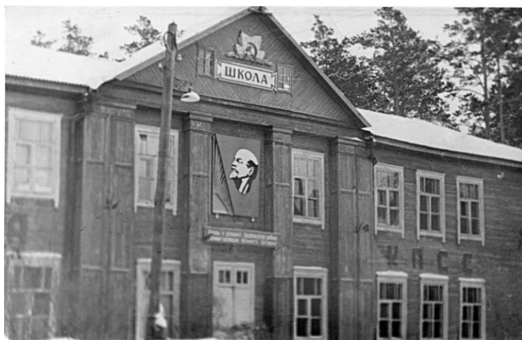
В 1957 году было построено двухэтажное деревянное школьное здание. Фото Владимира Пустовойтова, 1974 год.
