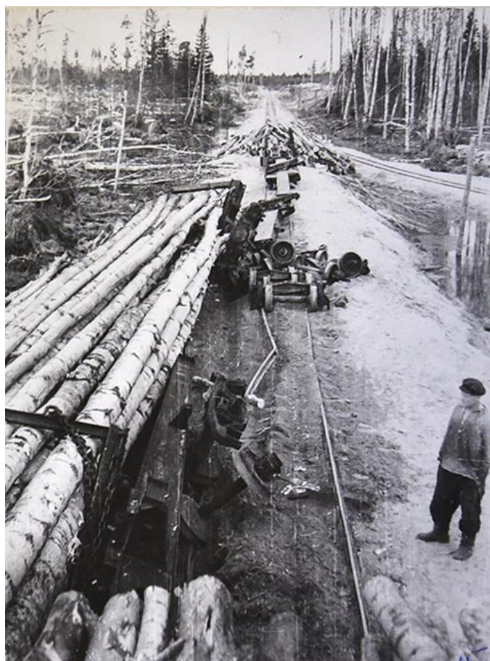
Авария произошла из-за неисправности стрелочного перехода. Разрушено пять ступов. Снимок из архива Музея леса, 1953 год.
