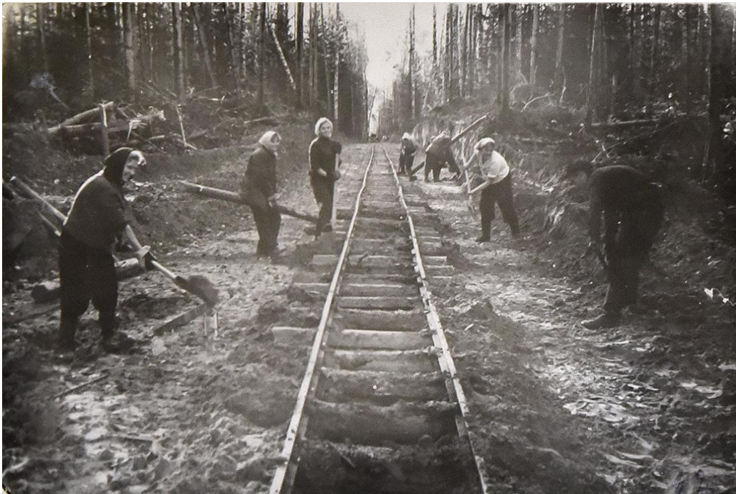
Подъемка путей баллансом, снимок из архива Музея Леса, 1954 год.
