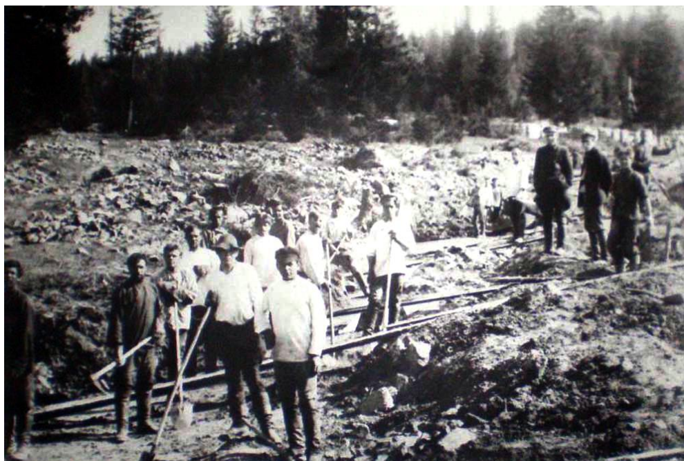
Строительство узкоколейки для леспромхоза, СССР, 30-е годы.
